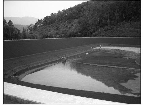
**管理型最終処分場** 安定型処分場跡地に隣接していて、埋め立て容量は22,000立米で八丈の半分以下、埋め立て期間は15年です（写真）。2年前に完成し、地下水感知システムも整備されていました。埋め立て場所は山の上であり、浸出水は、雪の少ない少し離れた低地の水処理施設までパイプで送られ、千曲川に放流されています。これも雪国特有の事情によるものでした。
